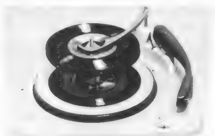
Ansicht des neuen viertourigen Telefunken-Plattenwechslers TW 504
